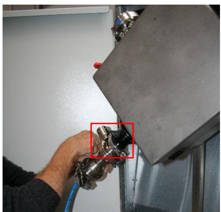
Fig. 115 Svuotamento alternativo del filtro senza valvola antiritorno
