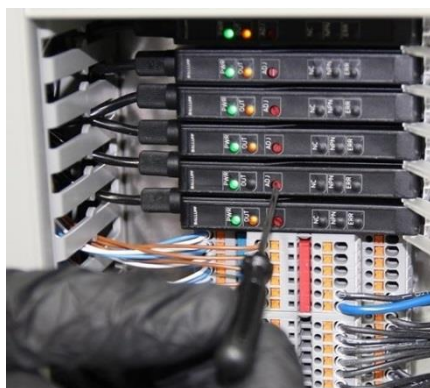
Fig. 138 Sensori del livello di riempimento amplificatore
