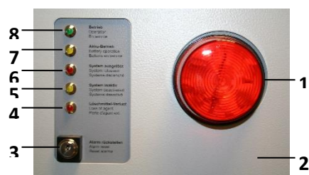
Fig. 32 Impianto antincendio ad argon, comando
