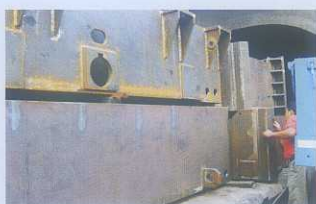
结构件回火处理 Structure tempering
