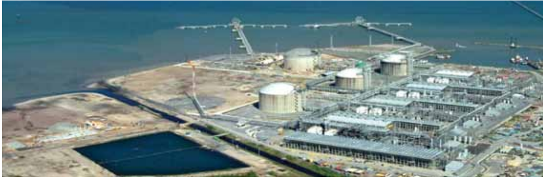
Baseload LNG liquefaction facility
