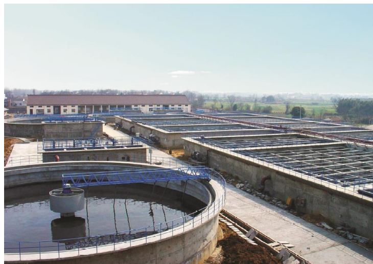
▲ 长兴县永清污水处理有限公司20,000吨每天印染污水集中处理工程 20,000T/D Dyeing Waste Water Treatment Project of Changxingjiapu Waste Water Treatment Co., Ltd
