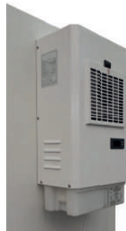
Aire Acondicionado en cuadro eléctrico
